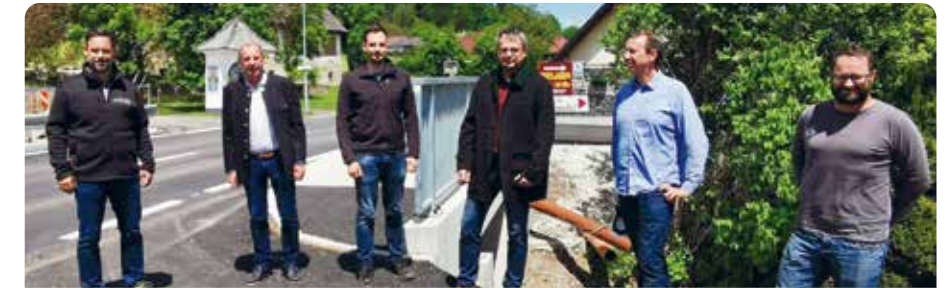
Vertreter des Landes Kärnten und der WLV-Gebietsbauleitung Kärnten Nordost mit Bgm. Harald Tellian nach Abschluss der Asphaltierungsarbeiten auf der B 92
