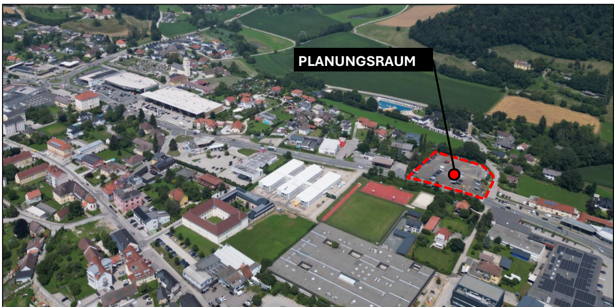
Abbildung 5: Siedlungsstruktur mit Blick Richtung Nordwesten (Quelle: Eigene Aufnahme)
